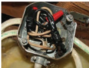
ცუდმა იზოლაციამ შეიძლება გამოიწვიოს ხანძარი წყარო: www.completepc.co.uk
