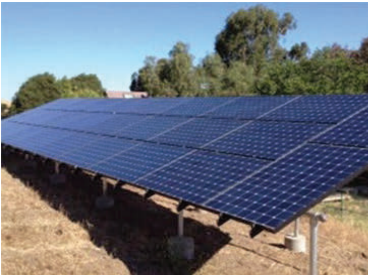
მიწაზე დამონტაჟებული პანელების მასივი წყარო: Melissa Van Hoorne, http://blog.solarmicronics.co
