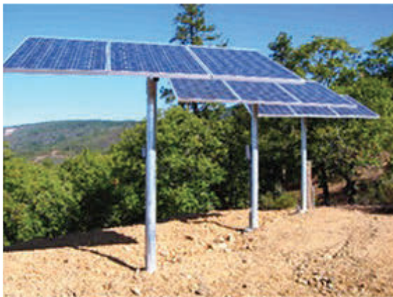
ბოძებზე დამონტაჟებული მზის პანელები - წყარო: www.acutrack.com
